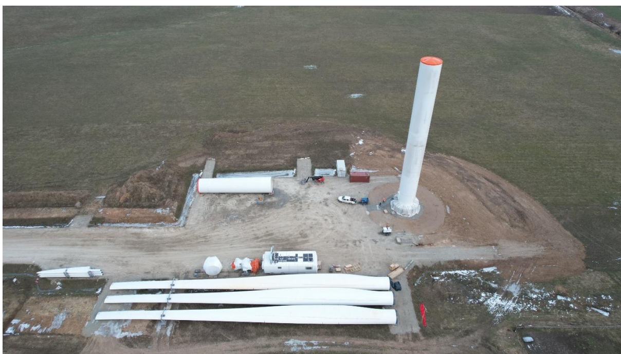
1.4.5. attēls. VES montāžas laukuma elementu izvietojums - European Energy vēja parka būvniecība Telšiai, Lietuva 2022. gadā
