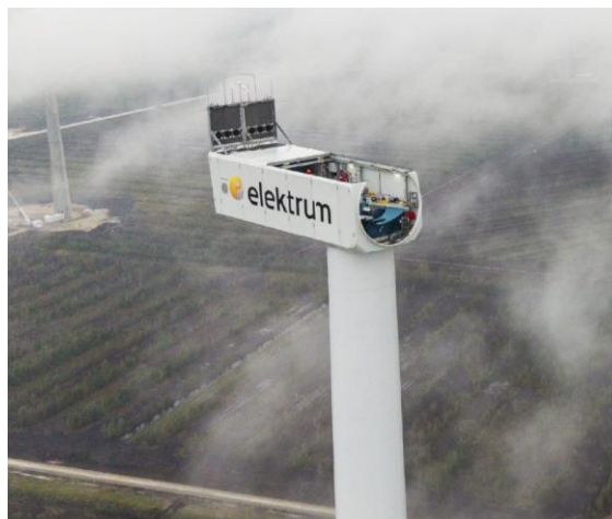
1.4.9. attēls. VES montāža - Laflora Energy vēja parka būvniecība Kaigu purvā 2025. gadā (avots: Latvenergo 15 )
