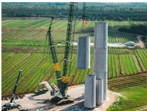
1.4.9. attēls. VES montāža - Laflora Energy vēja parka būvniecība Kaigu purvā 2025. gadā (avots: Latvenergo 15 )
