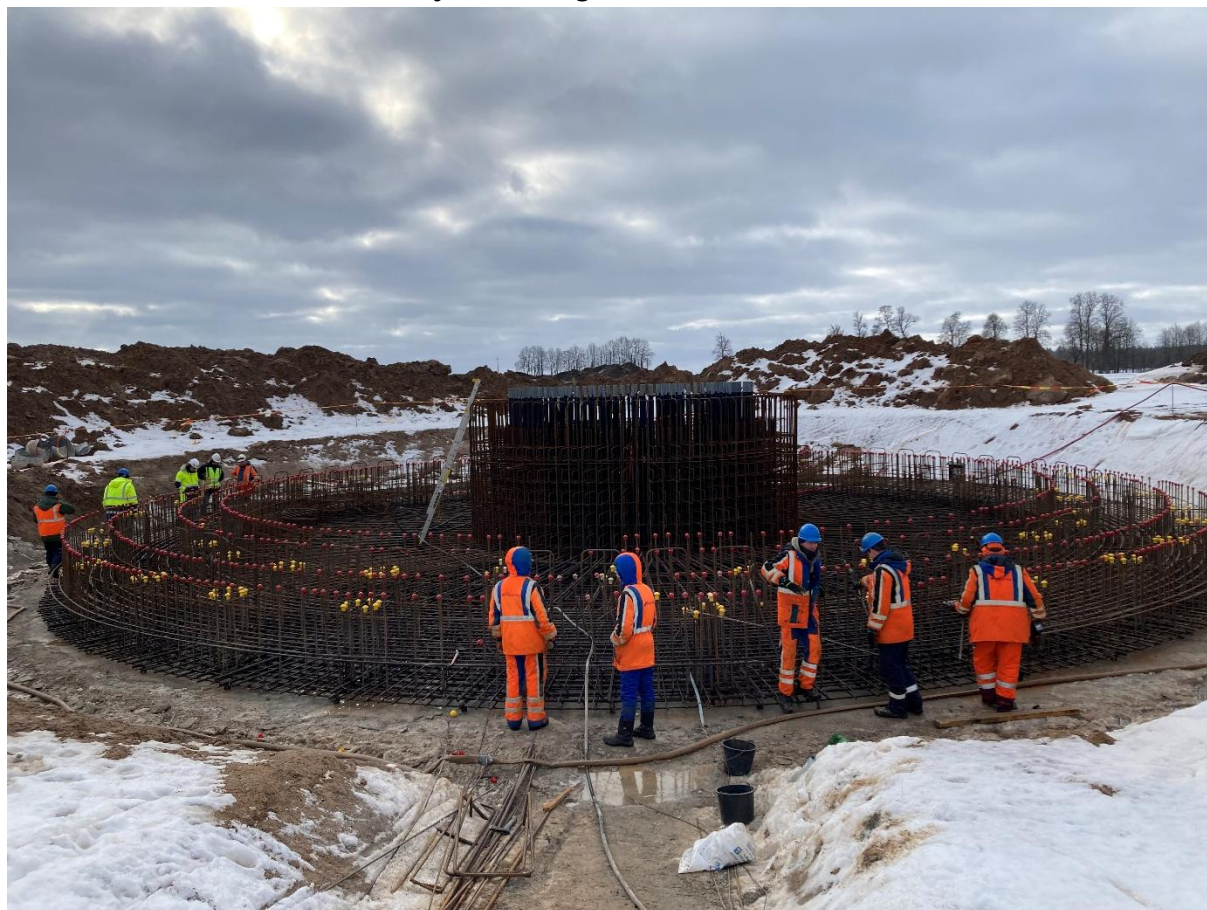
1.4.7. attēls. VES pamatu izbūve - European Energy vēja parka būvniecība Rokiškos, Lietuvā 2022. gadā
